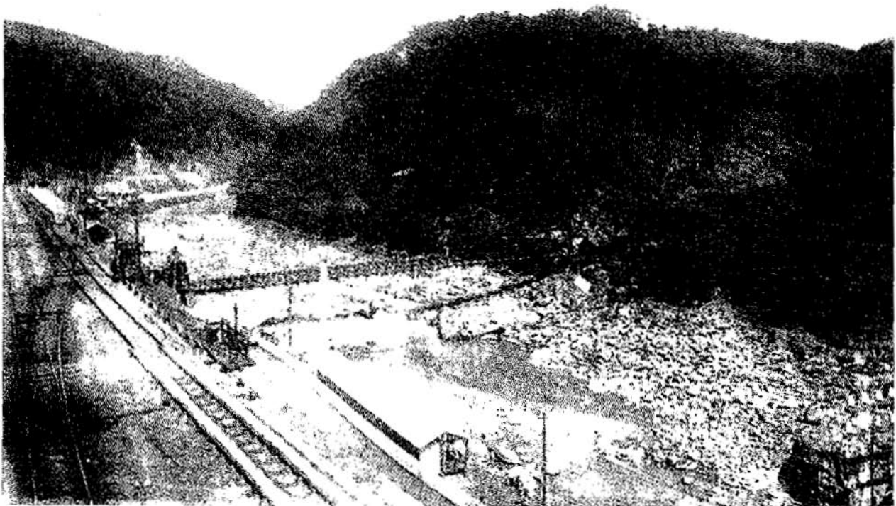
つり橋時代の城嶺橋
