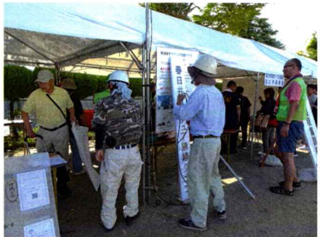
アンテナ設営工事
