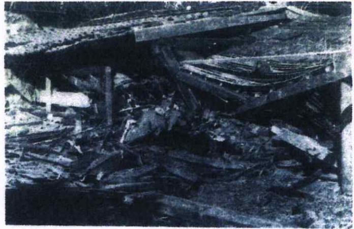
寄近町倒壊家屋
